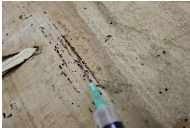
Injections de Paraloid B72 à l'acétone pour consolider les galeries d'insectes
