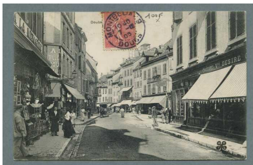
Rue des Febvres Montbéliard Archives départementales du Doubs
